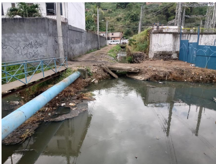
Foto 1 Sub Estação da Coelba
